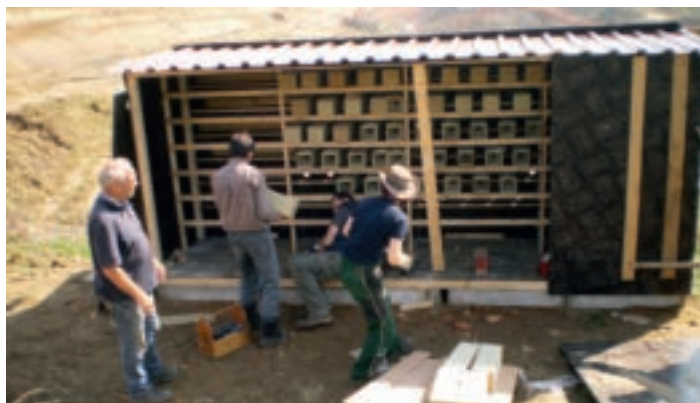
Bau einer künstlichen Uferschwalben-Nistwand in der Tongrube Bellenberg (© Hubert Ilg)
