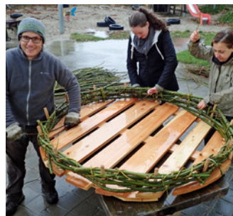
Wasserdurchlässige Plattform mit niedrigem Rand, in Höchstätt z.B. aus Holz.
